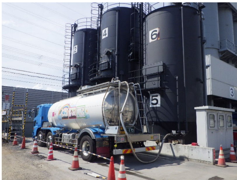
写真-中温化アスファルト搬入状況
